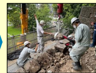
積み直し工事
