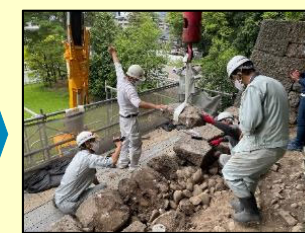
積み直し工事
